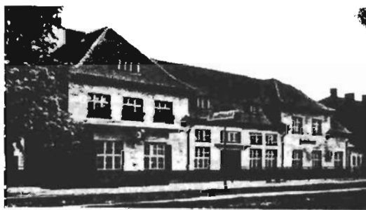
Der Bahnhof von der Gleisseite gesehen
