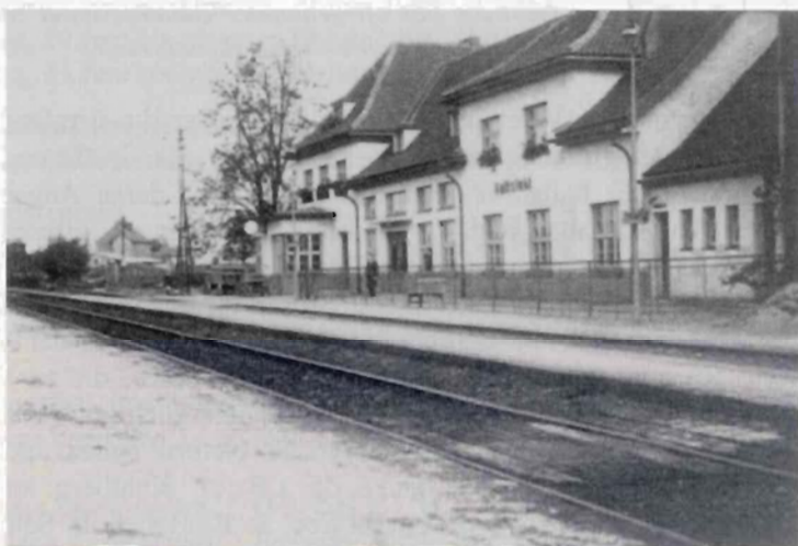
Das neue Guttstädter Bahnhofs-Abfertigungsgebäude wurde am 13.2.1935 eingeweiht. Hier eine Ansicht von der Bahnsteigseite aus. Links im Obergeschoß befand sich die Wohnung des jeweiligen Bahnhofsvorstehers. Dies war zuletzt bis 1945 Herr May. Auf der rechten Seite, über dem Namen Guttstadt, wohnte die Familie des Bahnhofs-Gaststättenpächters Hugo Kewer.
