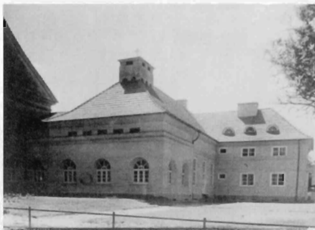
Das Evangelische Gemeindehaus nach der Einweihung am 9. Juni 1930. Der darin befindliche Saal mit der Bühne galt als der schönste in der ganzen Umgebung. Die Nebenräume, z.B. Küche und Garderobe, befanden sich im Kellergeschoß.
