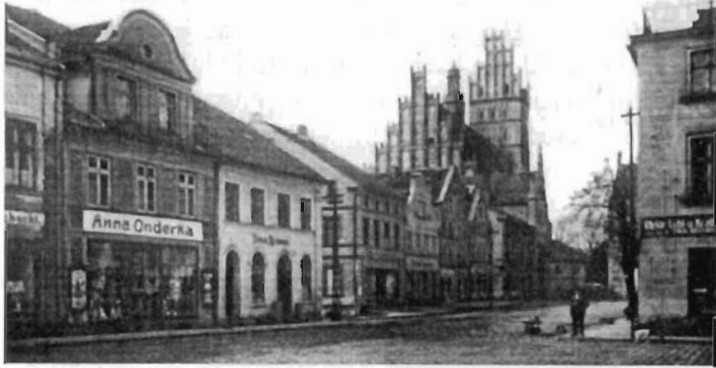
Foto (8): Etwa 1935. - Marktplatz Südseite; Linker Rand: Teil des Hauses Schacht; - daneben Markt 14: Anna Onderka, Hutgeschäft, vormals Poschmann. - Rechts daneben Markt 15: Eckhaus an der Mühlenstraße Franz Himmel, Kolonialwaren und Restaurant. - Markt 16: Eckhaus Georg Kuhnigk, später Leo Hasselberg, Kolonialwaren.
