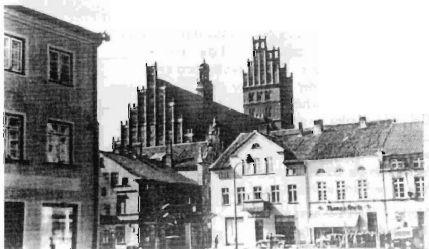
Foto (2b): 1938. Die oben genannten Häuser im Jahre 1938; das Kaufhaus Leo Keuchel und das Lebensmittelgeschäft Thams & Garfs. Das Rathaus ist jetzt nicht mehr vorhanden. Auf dem freien Platz wurden der Wochenmarkt und sonstige Veranstaltungen abgehalten. (Foto: Frau Dr. Lutterberg).
