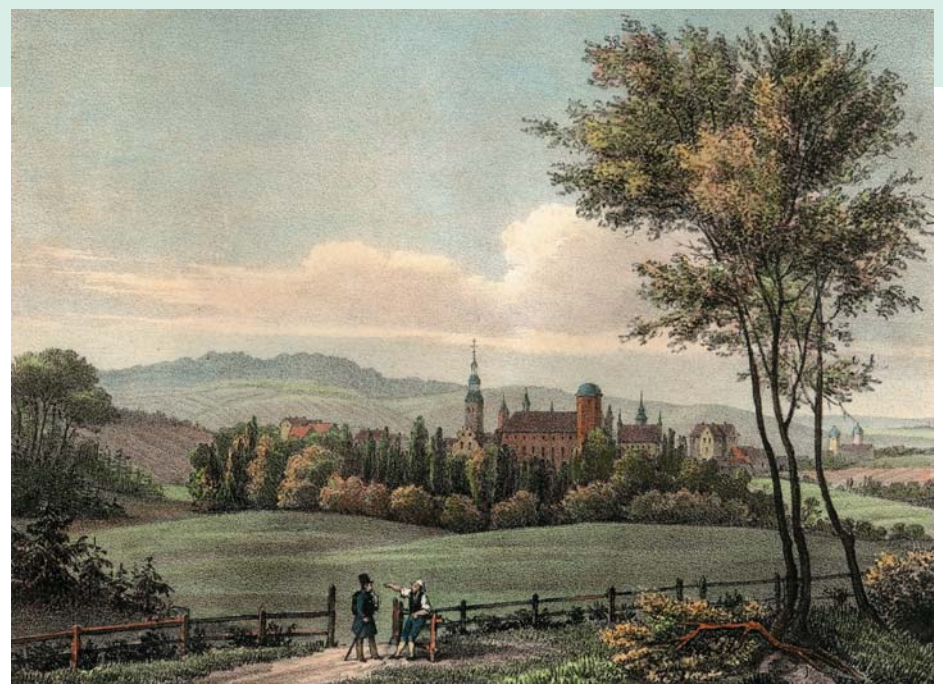
Blick auf Heilsberg. Der große Schlossturm hat noch die Turmhaube, die später bei einem Sturm (1818) zerstört wurde. Links vom Schloss ist der Turm der katholischen Pfarrkirche Peter und Paul zu sehen, rechts das Rathaus, dann das Hohe Tor und außen rechts die 1821–1823 errichtete evangelische Kirche. Gezeichnet von Angelika Gräfin zu Dohna. Lithographie: Lith. Inst. von L. Sachsen & Co. Berlin, 1833 Widok Lidzbarka. Wielka wieża zamkowa ma jeszcze kopułę, która później została zniszczona przez burzę (1818 r.). Na lewo od zamku widać wieżę katolickiego kościoła farnego św. Piotra i Pawła i Ratusz, następnie Wysoką Bramę, a na skraju, po prawej, zbudowany w latach 1821–1823 kościół ewangelicki. Rysunek Angeliki hrabiny von Dohna. Litografia: Instytut Litograficzny L. Sachsa & Co., Berlin, 1833 r.
