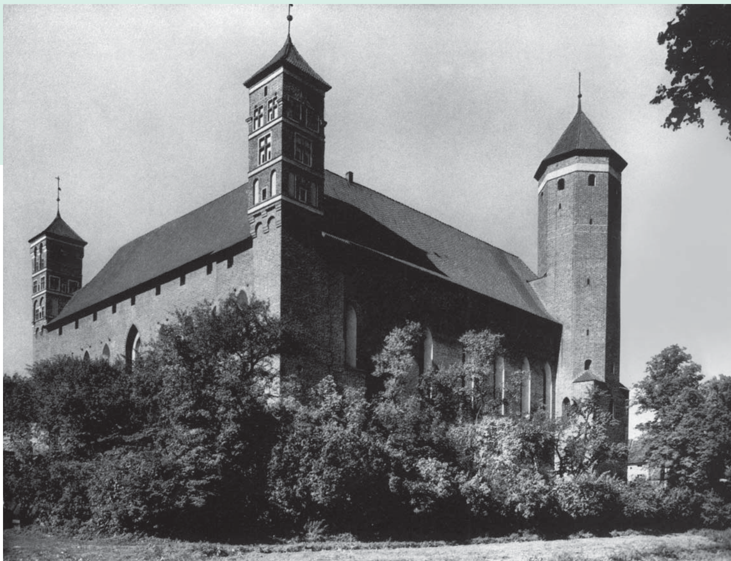
Ansicht der Südostseite des Schlosses nach Wiederherstellungsarbeiten. Zwischen 1926 und 1930, nach den vorbildlichen Renovierungsarbeiten (unter Leitung des Karl Hauke), hat das Bauwerk seinen ursprünglichen Charakter wieder erhalten. Auch die Dächer wurden neu mit roten Dachziegeln gedeckt. Den letzten Krieg überstand diese schöne Burg äußerlich unversehrt
